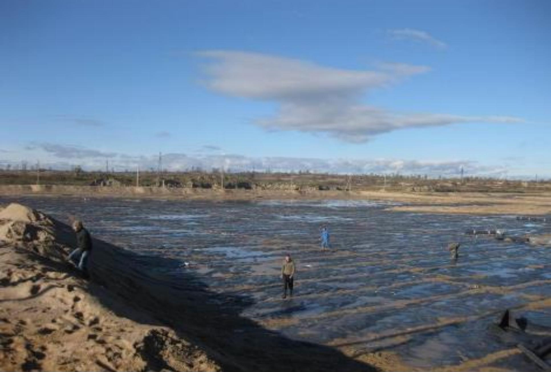
**Рис. 8.1. Укладка гидроизоляционного слоя в тело полигона «Барсуковка»**
