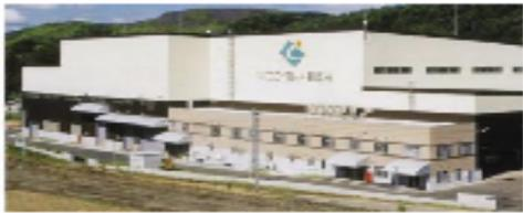
Хитачи, Япония – завод по переработке отходов в электроэнергию методом плазменной газификации, который функционирует с 2003 г. и соответствует строгим экологическим требованиям. Данное производство осуществляет обработку 200-280 тонн в сутки смеси из отходов автомобилей, обрезков бумаги и твердых бытовых отходов для производства электроэнергии;
